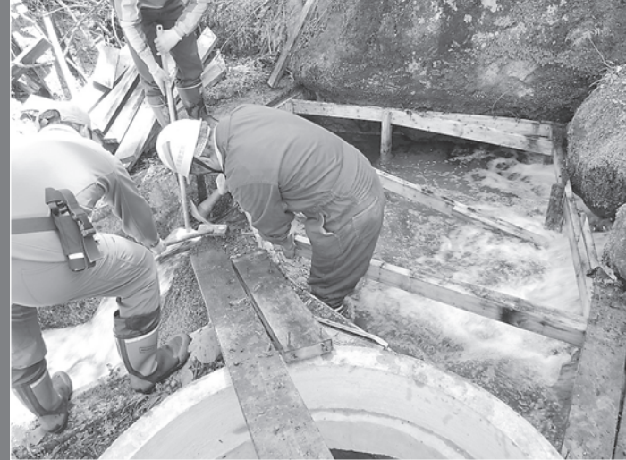
▲水源地の点検作業
