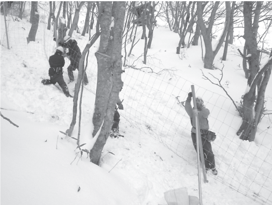
▲野生動物対策フェンスの設置
