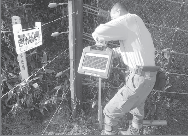
▲羅臼での電気柵設置の様子
