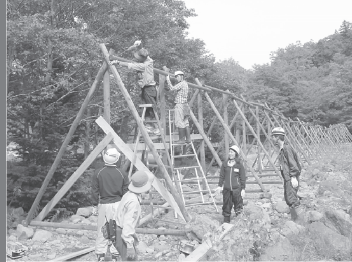
▲岩尾別川沿いの防鹿柵設置作業
