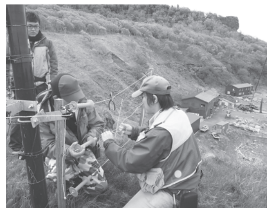
▲文吉湾での電気柵設置作業
