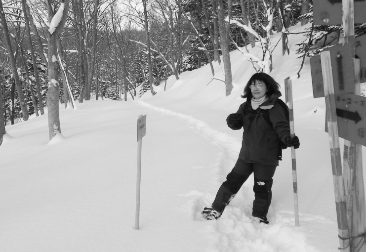
▲「スノーシュー・歩くスキーコース」の設置作業
