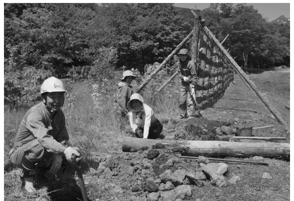
▲ 防鹿柵の修理の様子。
