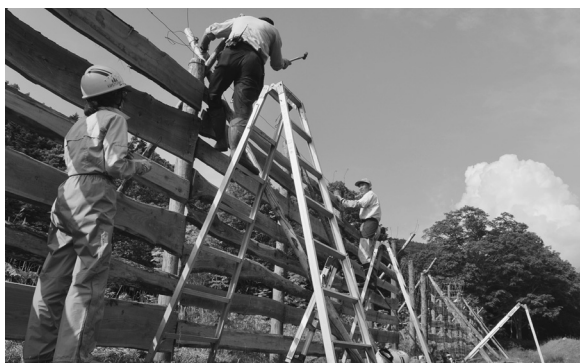
▲ 防鹿柵の補修作業の様子。
