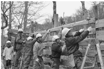
▲ 防鹿柵の修理の様子。
