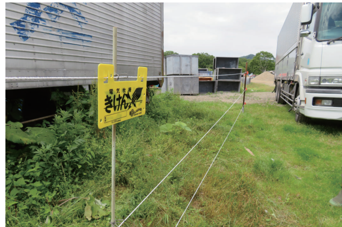
(左) 水産加工場に設置された電気柵 (右) 電気柵の山側に姿を現したヒグマ 草や物が触れると漏電して電圧が下がってしまうので、定期的な草刈りなど細やかなメンテナンスが欠かせない
