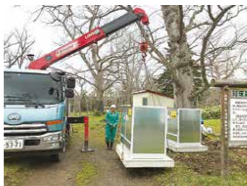
とれんべアの設置には重機が必要
