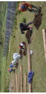
この日は「防風柵」の設置作業。知床の強い風から苗木を守るために柵を作ります。一から穴を掘って、柱を立てて、板を張るという結構な重労働です。
