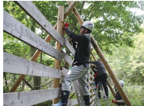
河畔林での防鹿柵の設置作業
