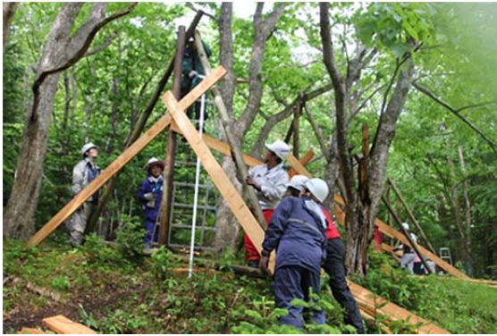
写真 1-19. トライアングルの組み立て (2015 年 5 月).
