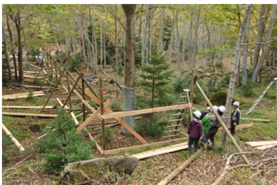
写真 1-13. 設置作業の様子（2011 年 10 月）。
