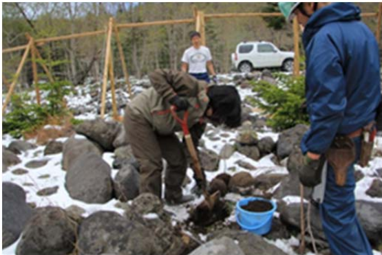
写真 1-9. カツラ苗の植樹作業① (2014 年 5 月) .
