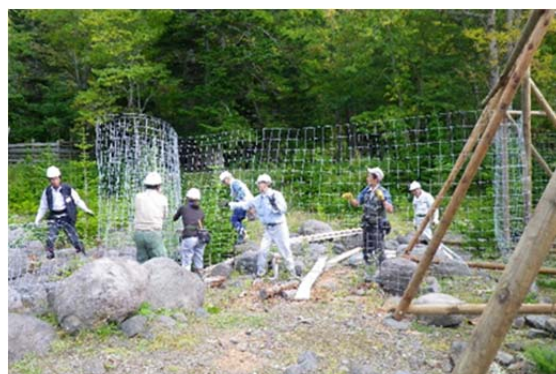
写真 1-18. フェンス張り作業の様子（2014 年 9 月）。
