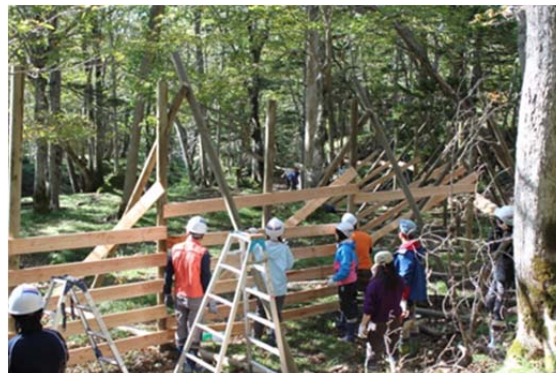
写真 1-14. 増設作業の様子（2012 年 10 月）。
