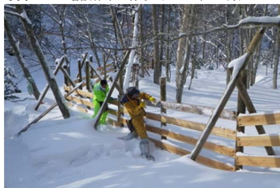
写真 1-16. かさ上げ作業の様子（2013 年 2 月）。
