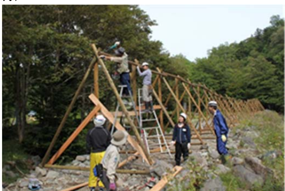
写真 1-17. 設置作業の様子（2013 年 9 月）。
